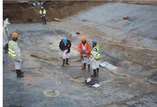
Figure 5. Réparation du tassement du panneau P102E en 2009
